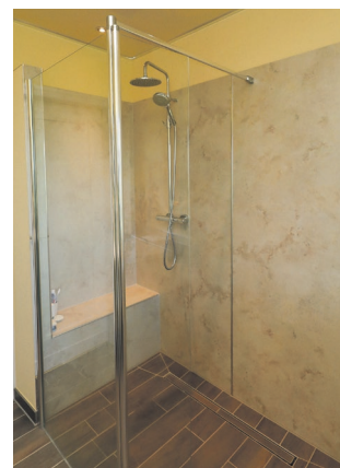
Die großzügige Dusche mit einer besonders pflegeleichten und fugenlosen Rückwand.
